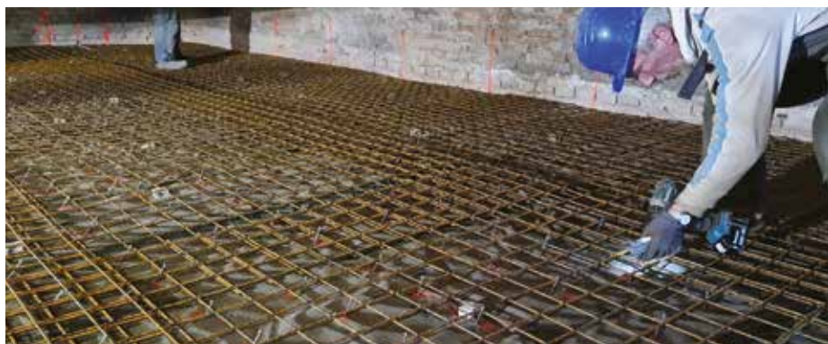
Sovprežne plošče les - beton
