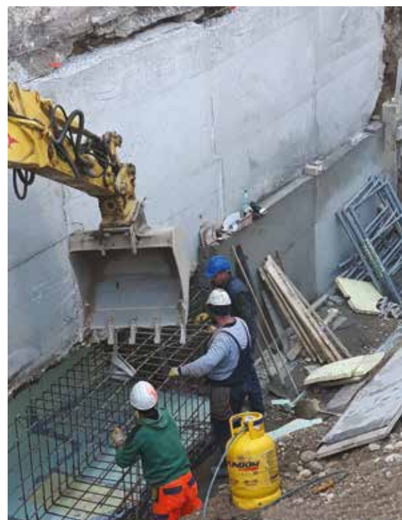
Podbetoniranje severne fasadne stene
