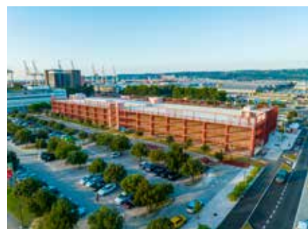
Garažna hiša v Kopru, grajena po tehnologiji ponapetih AB elementov
